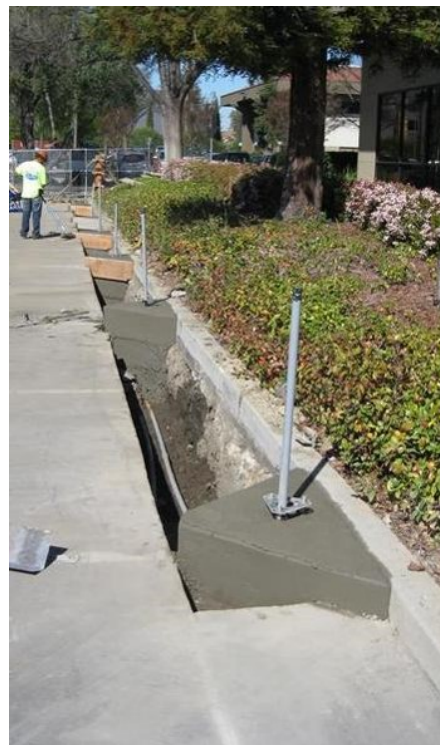
Pouring the pad
